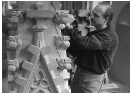
In der Freiburger Münsterbauhütte Foto: privat
