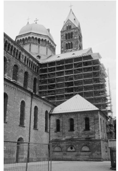
Eingerüstetes südliches Querhaus.
