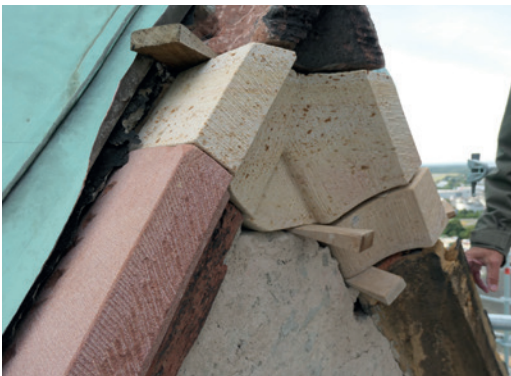
Südostturm, Gerüstlage 31 Steinaustausch und Vierungen
