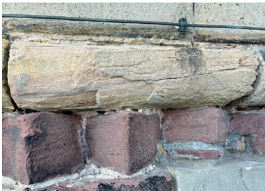
Südostturm, Gerüstlage 28 Steinschäden
