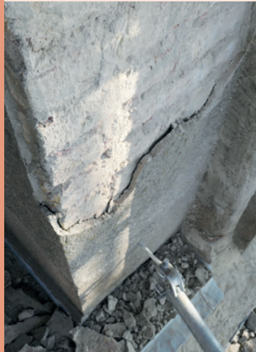
Sönderturm, Gerüstlage 29 Putzschäden
