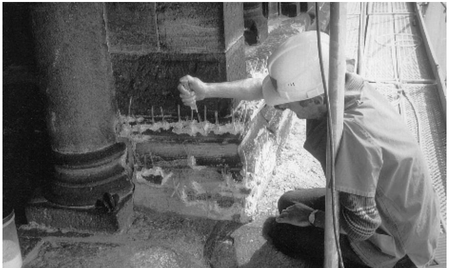
Risseinjektion mit kieselig gebundener Masse am Gesims der Galerie.
