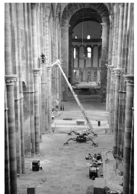
Reinigung der Mittelschiffwände. Foto: Stoltz
