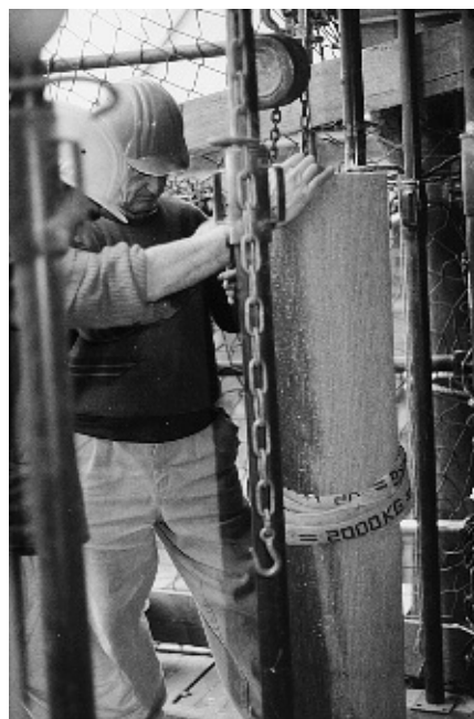
Die Steinrestauratoren Franz Günther und Raimund Kraus beim Sichern von Stützen der Zwerggalerie.
